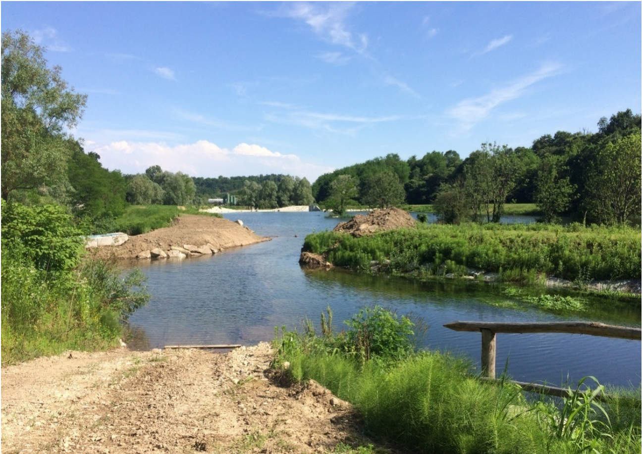
Foto 3 - Fiume Olona, collaudo vasca di laminazione (15 Giugno 2019).
