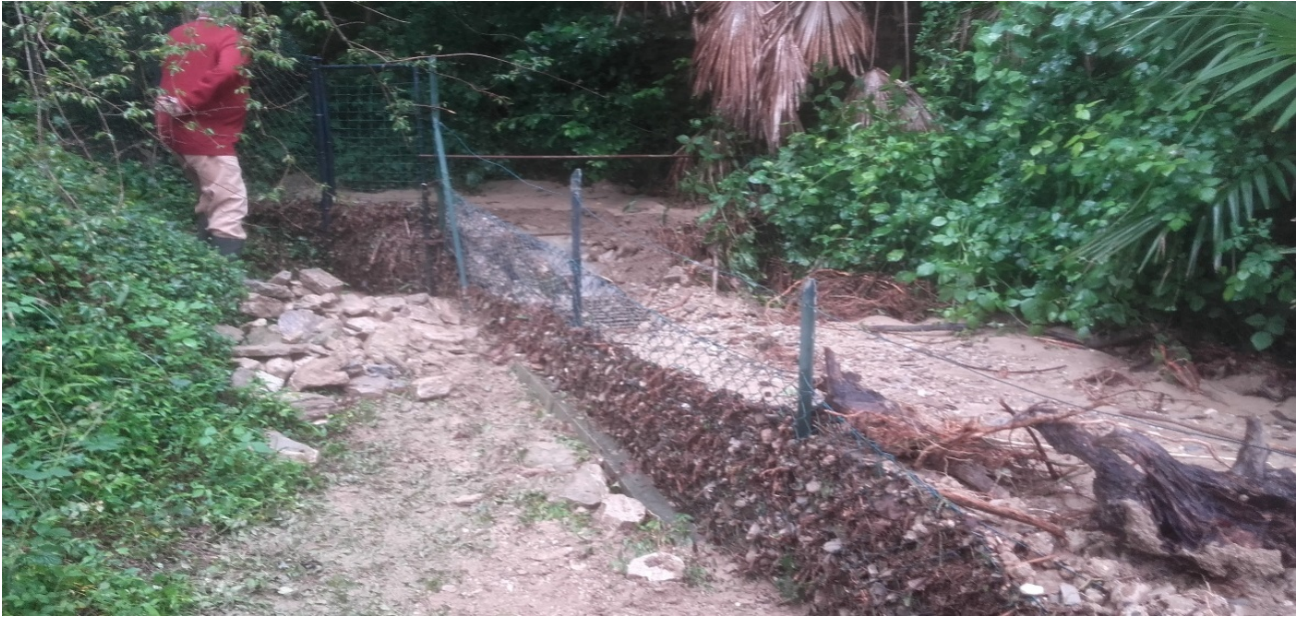
Foto 14 - Interramento del tombotto e del collettore, oltre la rete metallica è presente una griglia (tombotto a monte).
