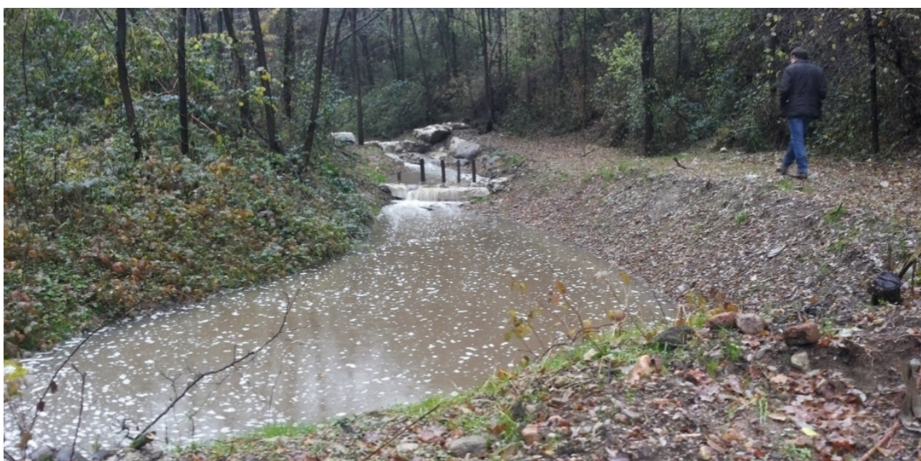
Foto 16 - Bacino di trattenuta detrito e di laminazione realizzato nell'anno 2014 a monte del tombotto sottopassante la via Monte Nero e via Peschiera.
