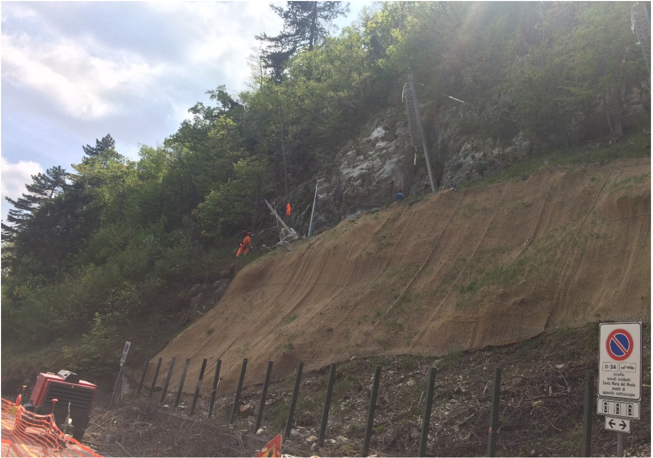
Foto 6 - Fase di realizzazione delle barriere paramassi (2018).
