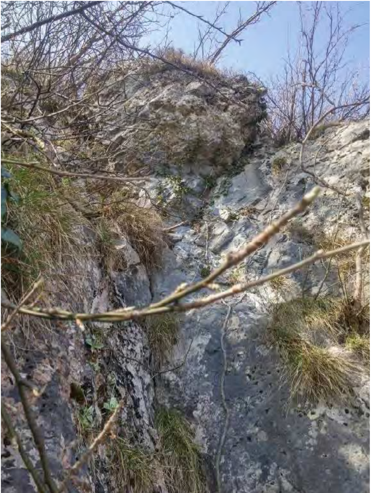
Foto 8 - Versante e ammassi rocciosi non protetti.
