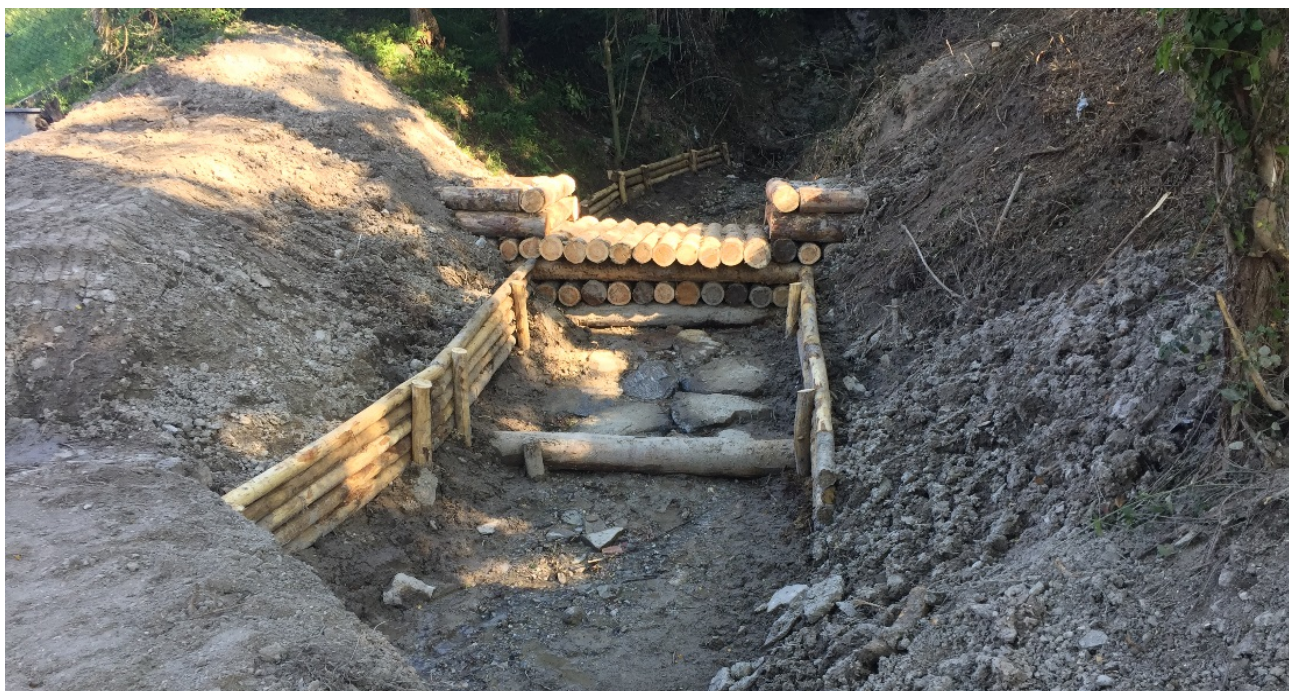
Foto 27 - Briglia di presidio realizzata a monte del ponte.
