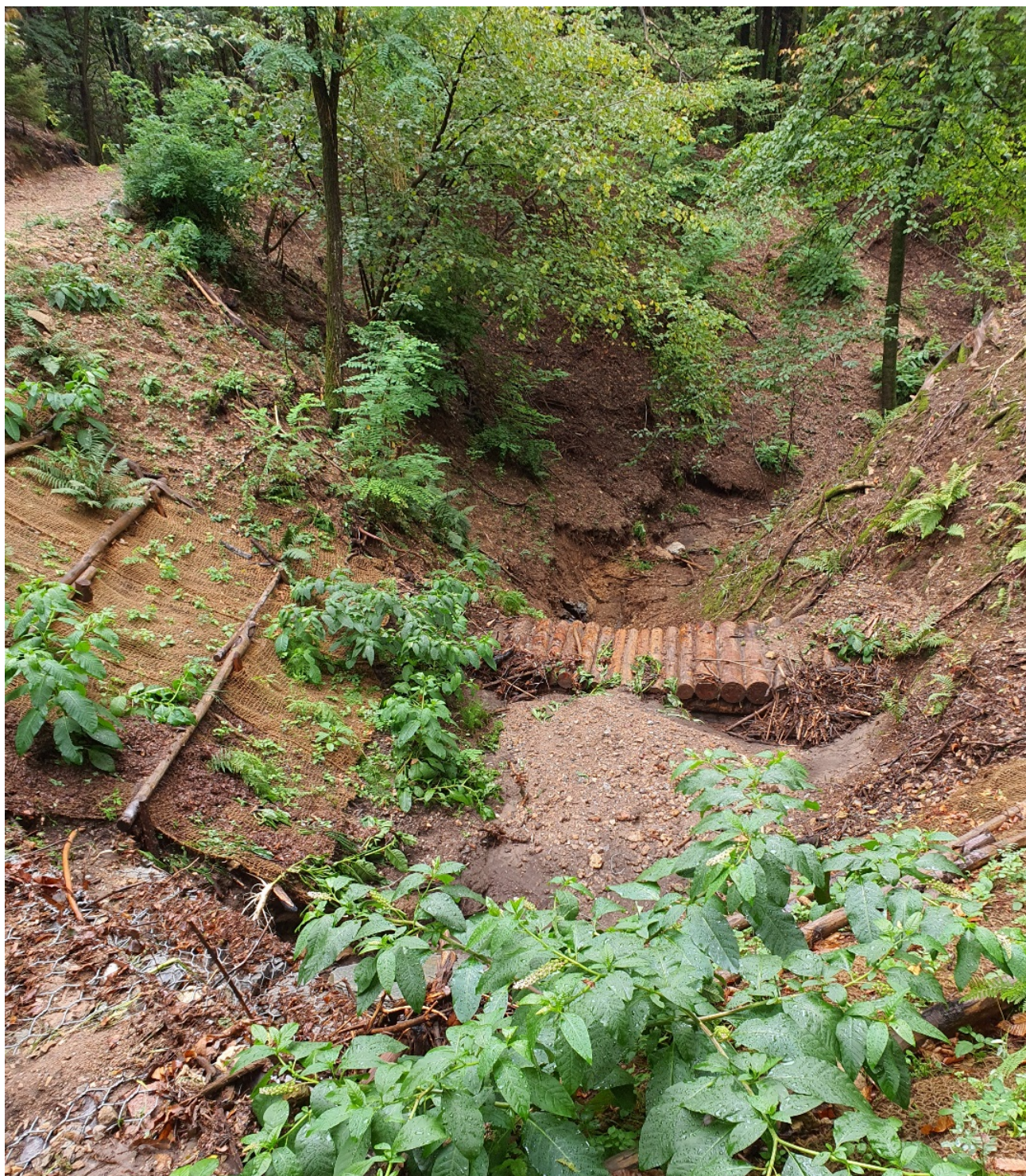
Foto 10 - Briglia e sistemazione di versante.
