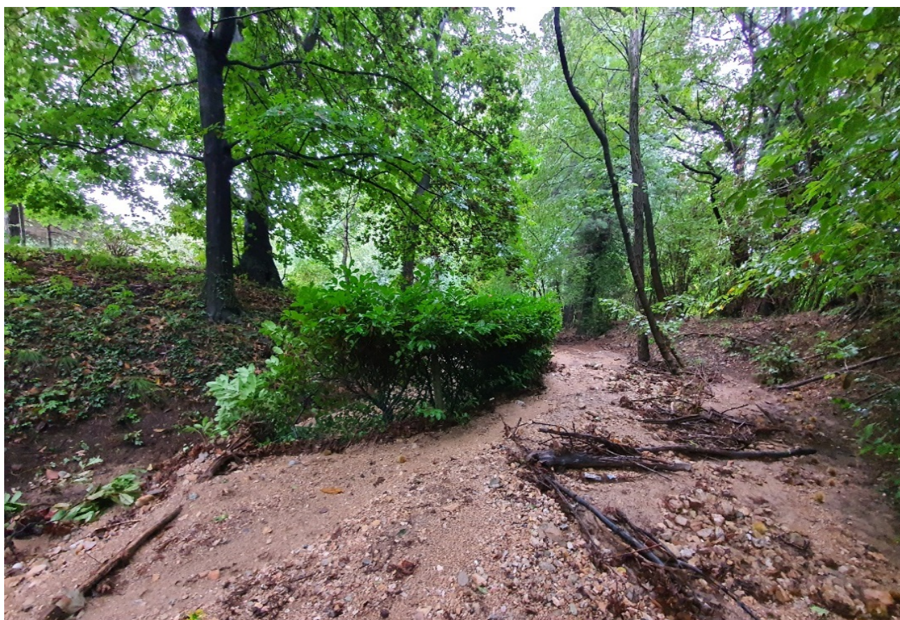
Foto 9 - Accumuli detritici - sovralluvionamento.
