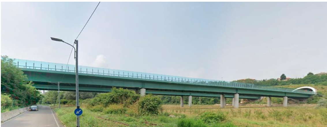
Figura 17 – Viadotto della A36 Pedemontana Lombarda a Solbiate Olona e Gorla Maggiore. Fonte: Google Street View.
