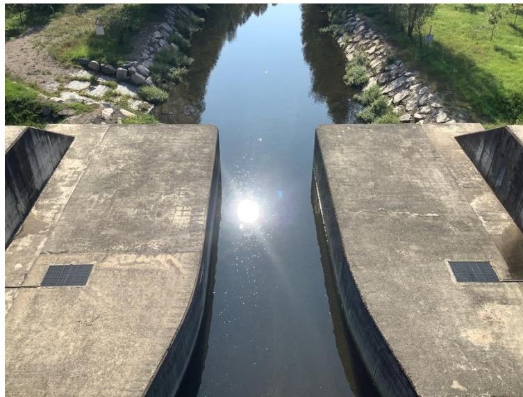
Figura 6 - Tronco di controllo a valle della vasca di dissipazione (vista da coronamento).
