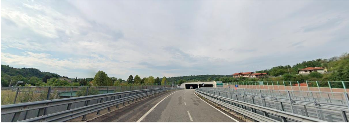
Figura 16 – Viadotto e svincoli della A60 Pedemontana Lombarda in località Ponte di Vedano. Fonte: Google Street View.
