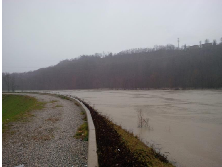
Figura 37 - Vasca di laminazione in località Mulini di Gurone durante l'evento di piena del 25-26 dicembre 2013. Fonte: GVPC di Malnate.
