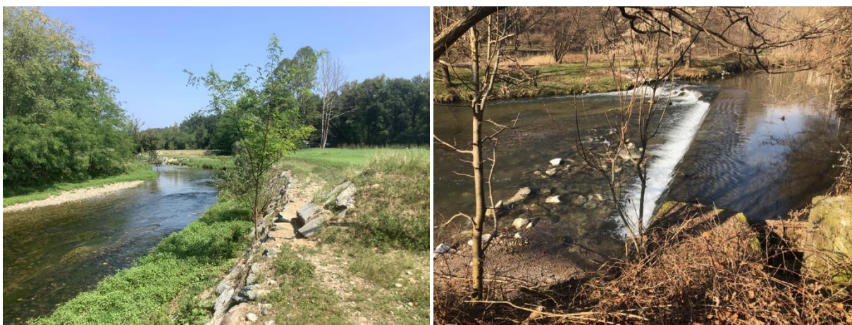
Figura 20 – Argini rilevati e rinforzati con scogliere e massi ciclopici in località Torba a Gornate Olona (a sinistra) e soglia in calcestruzzo a Lonate Ceppino (a destra).
