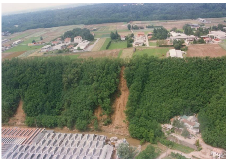
Figura 31 – Frane superficiali sulla scarpata in sponda destra in località Molino Lepori all’altezza della Tintoria Zerbi a Lonate Ceppino, con interessamento dell’alveo. Fonte: Archivio CNR IRPI Torino.
