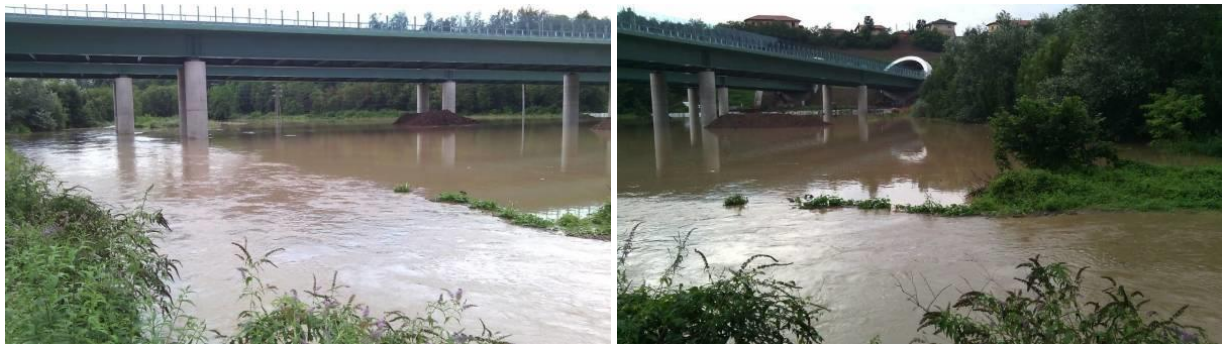
Figura 44 – Allagamenti localizzati nel settore meridionale della Valle Olona all'altezza del viadotto della Pedemontana A36. Fonte: Varese News.
