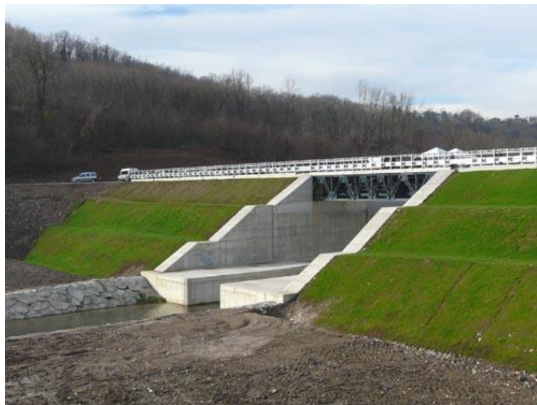
Figura 3 - Paramento di valle.
