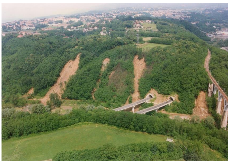
Figura 29 – Frane superficiali e colate sul versante in destra orografica del Fiume Olona all’altezza del viadotto e delle gallerie della SS712 Tangenziale Est di Varese e del viadotto ferroviario a Malnate, a monte della diga. Fonte: Archivio CNR IRPI Torino.
