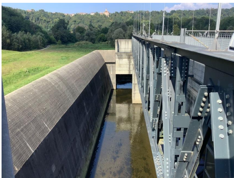
Figura 7 - Manufatto di regolazione (vista da coronamento). Sono visibili la soglia sfiorante di superficie e lo scarico di fondo regolato sul lato sinistro, la vasca interna di dissipazione e la passerella metallica di accesso.
