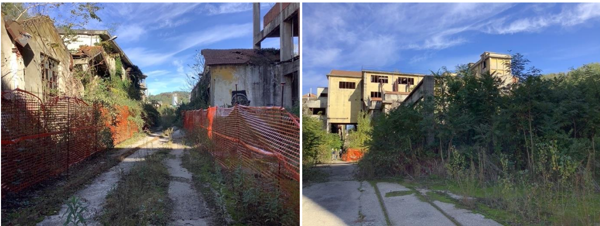
Figura 23 – Strutture fatiscenti e abbondante vegetazione all'interno dell'area dismessa della ex-Cartiera Vita-Mayer a Cairate.
