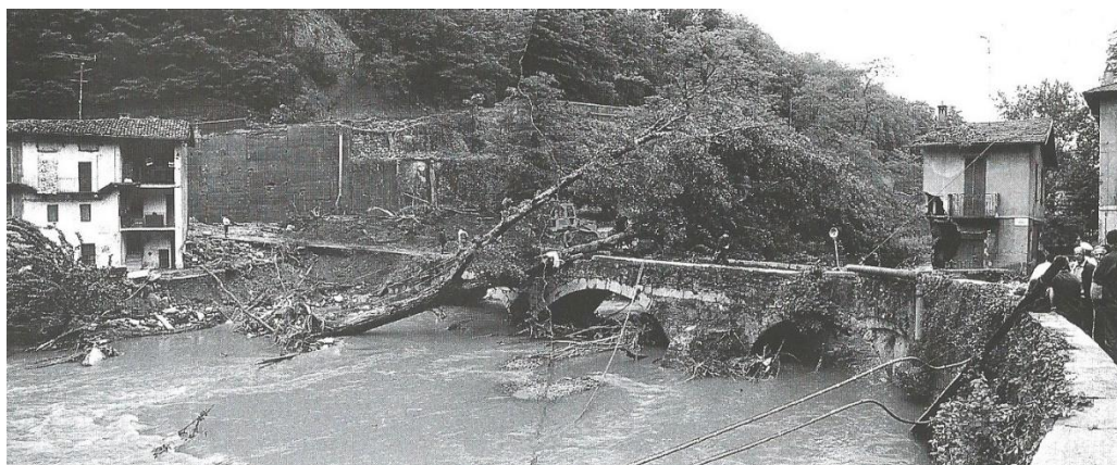
Figura 26 -Abitazione in località Mulini di Castiglione Olona parzialmente demolita per erosione spondale e Ponte Medioevale danneggiato dall’impatto di detriti e alberi provenienti dalla scarpata destra. Fonte: Archivio CNR IRPI Torino.
