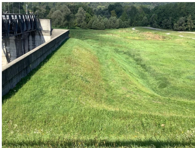
Figura 4 - Particolare del paramento di monte con i rinfiandi di materiali sciolti sagomati.
